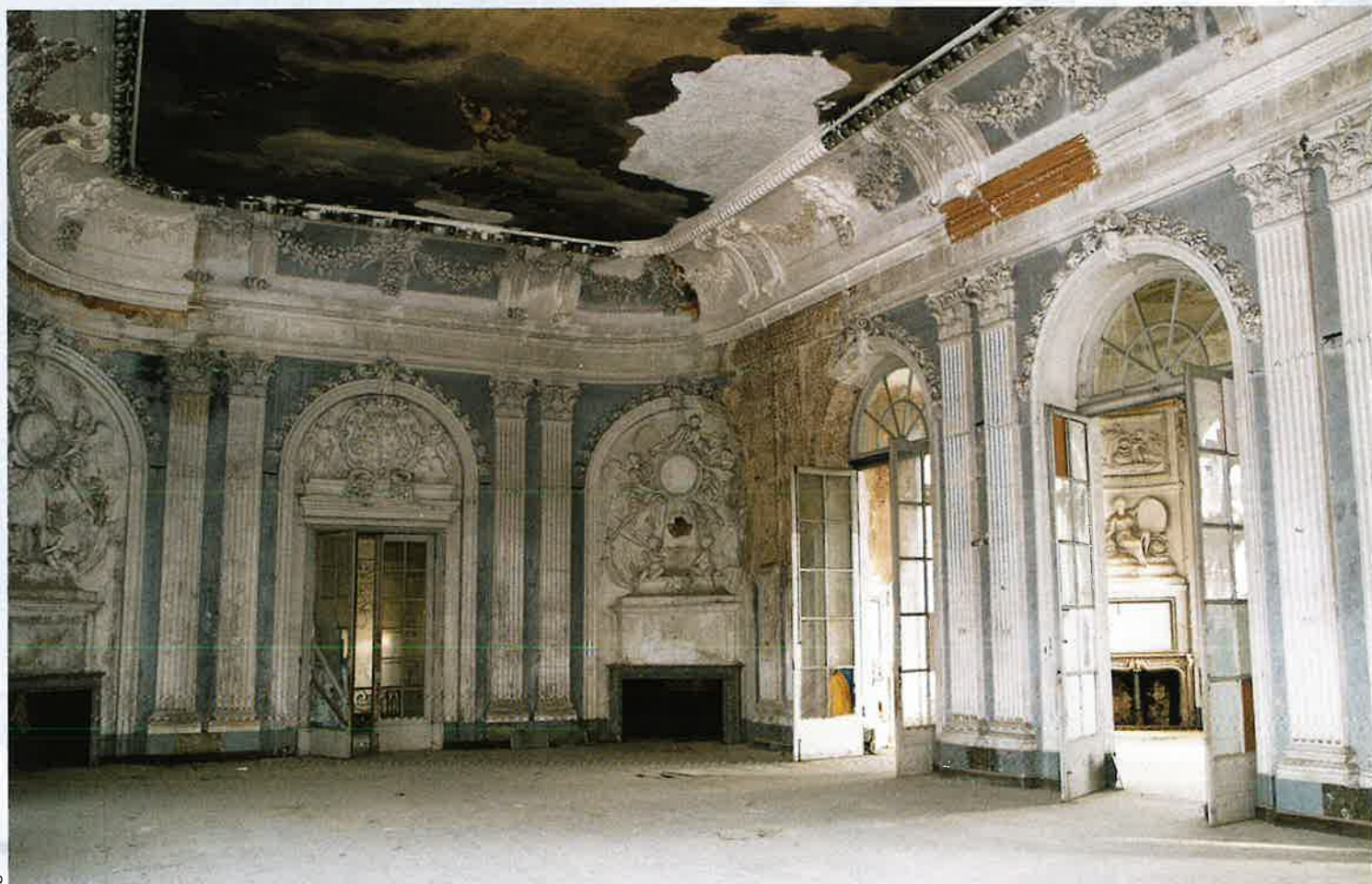
Salle de bal, angle sud-ouest, vue d'ensemble (33).
