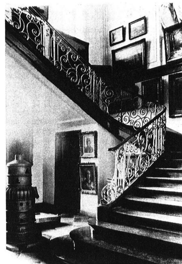
Escalier avec rampe en fer forgé. Copyright A.C.L.
